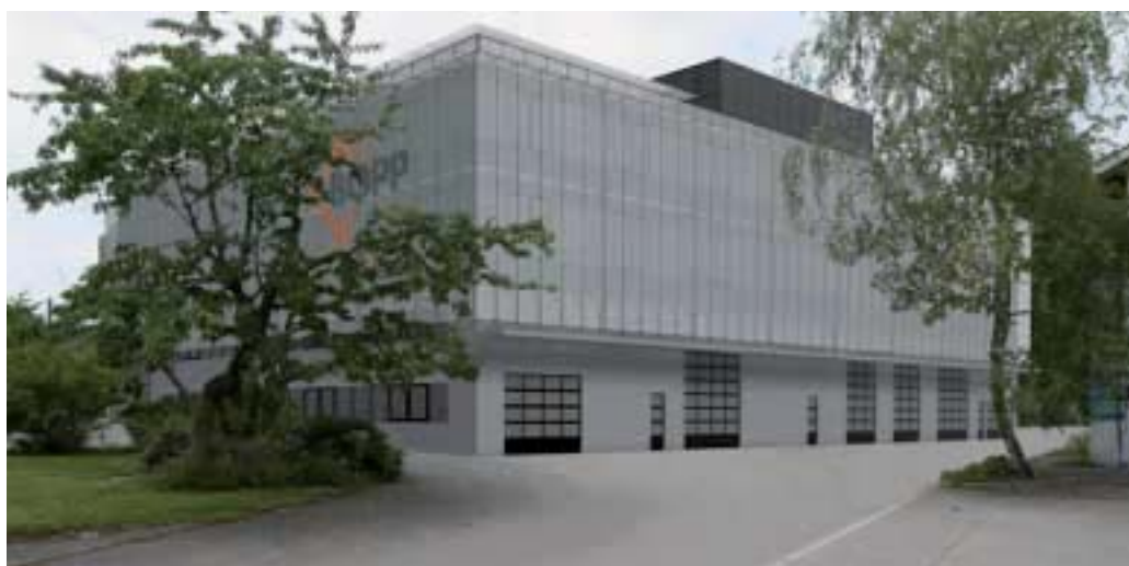
Neuer Hauptsitz in Zürich-Affoltern
